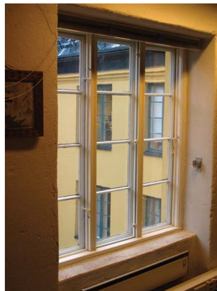
Når man utformer og monterer nye innvendige varevinduer er det viktig å se til at lysåpningene ikke blir mindre på indre enn på ytre vindu, midtpost og rammer må ikke være bredere enn i det ytre. Det er best å plassere det nye innervinduet nær yttervinduet for å redusere tap av lys og utsikt. Det synes særlig når man ser på vinduet fra siden, slik som her. Bildet til venstre viser tradisjonelle innevinduer. Bildet til høyre viser tilsvarende vindu med glass koblet direkte på ytterramma uten egen ramme for det nye glasset.
