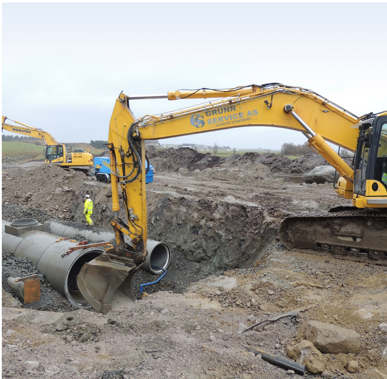
Figur 10: Oppdimensjonering av rør som en del av flomsikringsprosjektet på Vigrestad.
