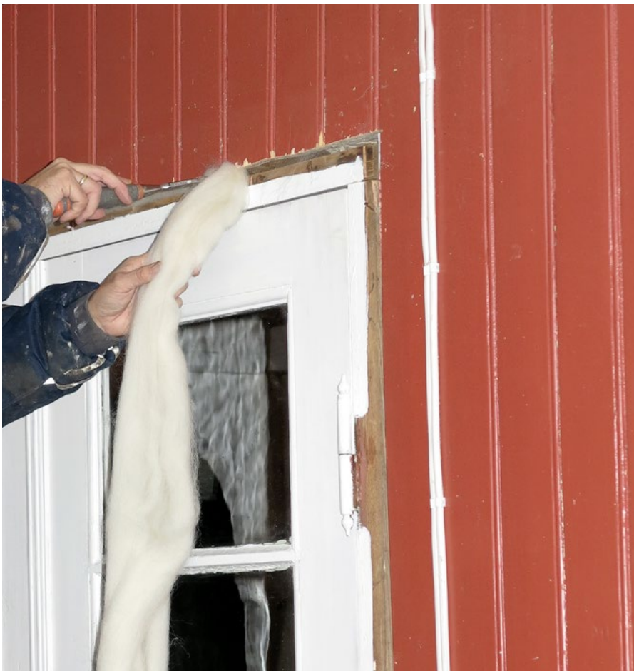
Tetting med ull rundt gammel og flott dør.
